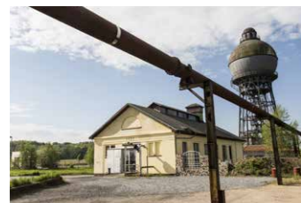
Umformerstation auf der Ilseder Hütte, Foto: André Walther
